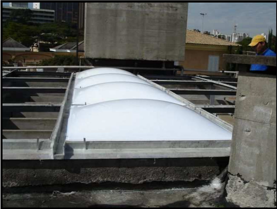
Domos Instalado com Calhas Intermediaria
