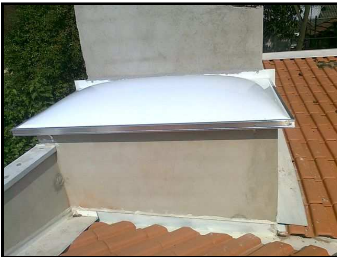
Rufo Calha Junto a Parede
