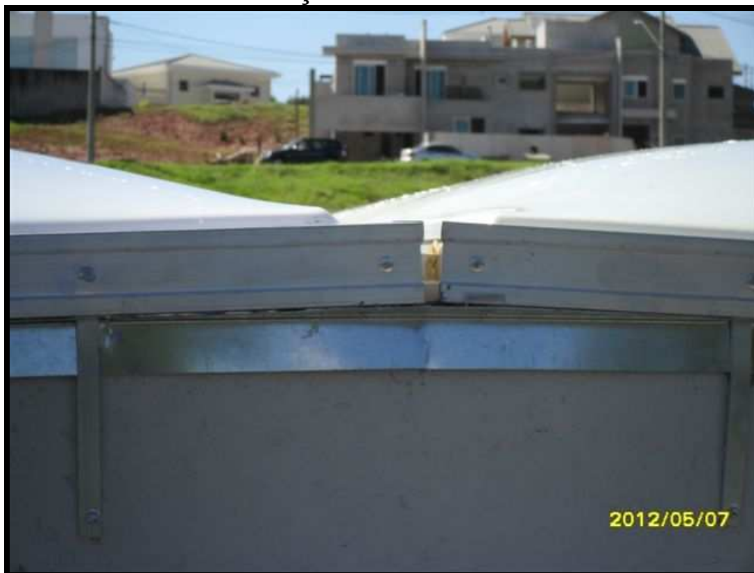
Detalhe da Ventilação Permanente e Calha Central
