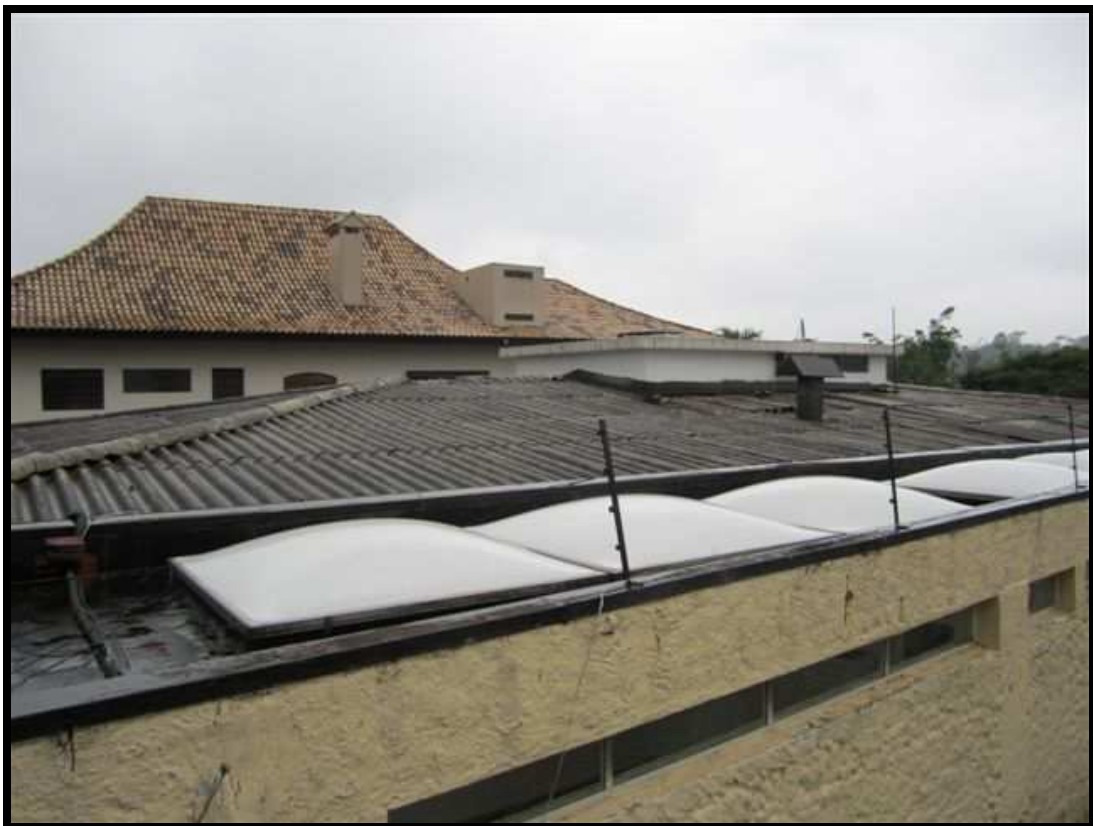
Domos Instalado com Calhas Intermediaria
