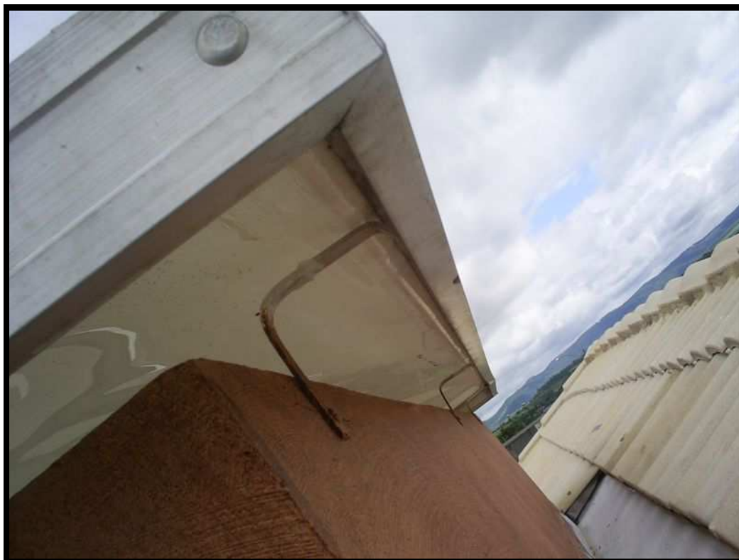
Detalhe da Ventilação Permanente e Calha Central
