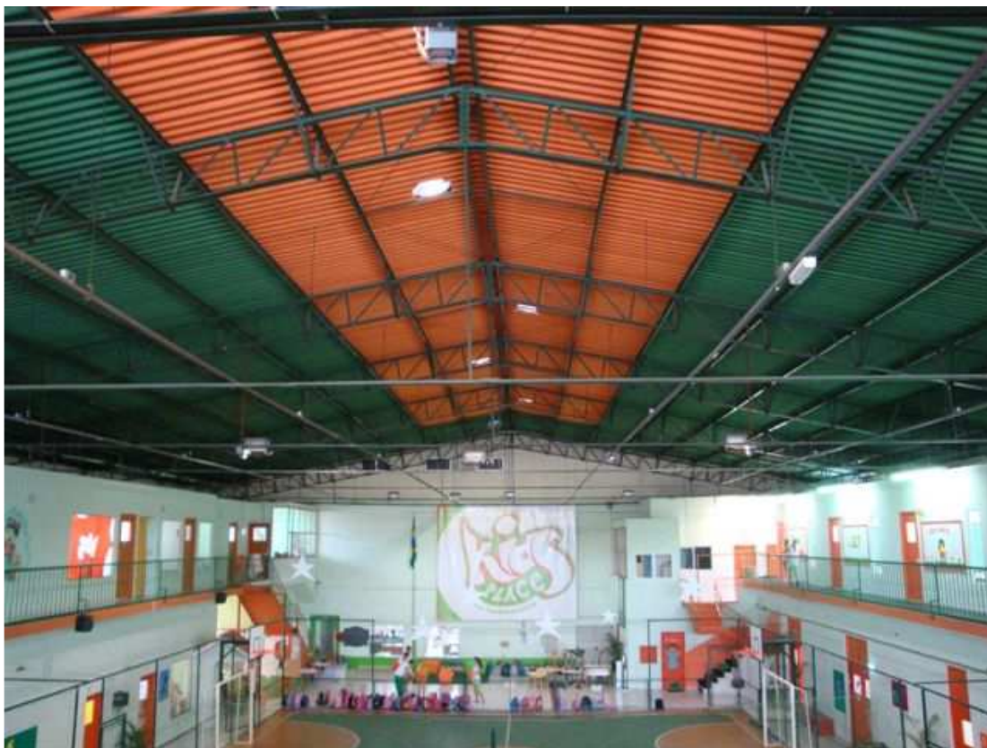
VENTILAÇÃO COM DOMOS TIPO 1630 (2010) FIBERGLASS
